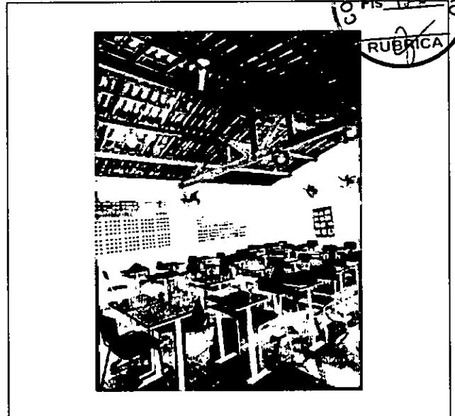
FOTO 10- SALA DE AULA
