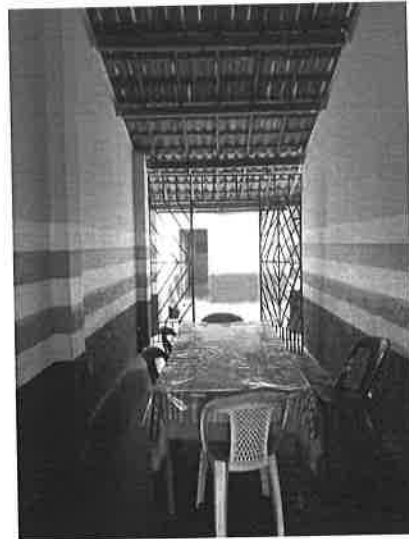
FOTO 38 - CIRCULAÇÃO ACESSO A CANTINA
