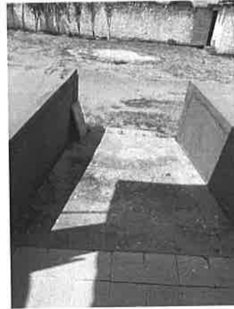
FOTO 30 - RAMPA DE ACESSIBILIDADE
