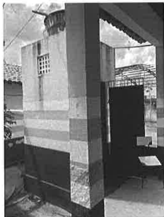
FOTO 27- DEP SITO/ESTRUTURA CAIXA D' GUA
