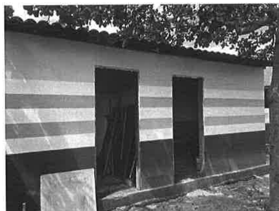
FOTO 48 - DEPÓSITOS AO LADO DO AEE
