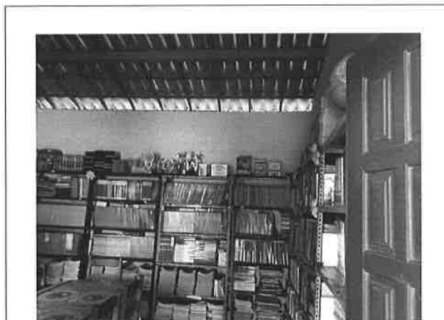
FOTO 28 - SALA DE LEITURA/BIBLIOTECA
