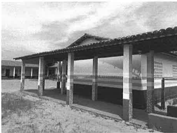
FOTO 07- HALL DE ENTRADA PRINCIPAL
