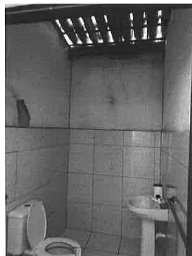
FOTO 54 – WC SALAS ED. FISICA VIZINHO A QUADRA
