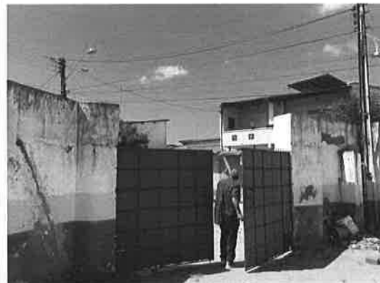
FOTO 08- PORTÃO DE ACESSO VEICULOS
