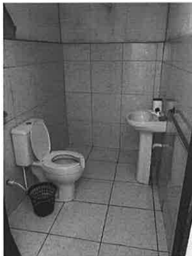
FOTO 53 – WC SALAS ED. FISICA VIZINHO A QUADRA
