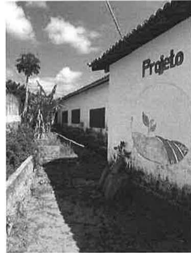
FOTO 10- CIRCULAÇÃO LATERAL / PLANTAÇÃO
