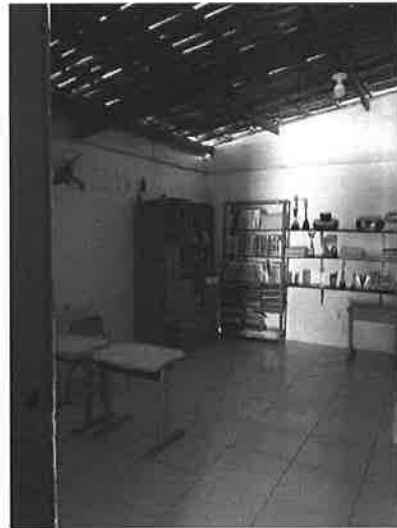
FOTO 52 – SALAS DE ED. FISICA VIZINHO A QUADRA
