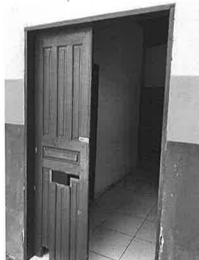
FOTO 46 - PORTA ACESSO SALAS DE ED. FISICA
