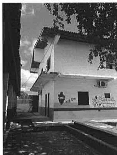
FOTO 27- VISTA PAVIMENTO SUPERIOR
