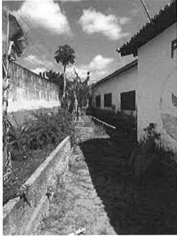
FOTO 09- CIRCULAÇÃO LATERAL / PLANTAÇÃO
