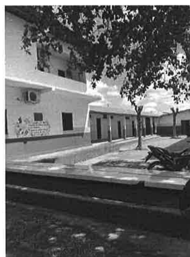
FOTO 26 - VISTA PAVIMENTO SUPERIOR
