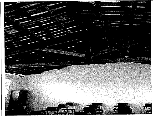
FOTO 33 – TELHADO SALA DE AULA
